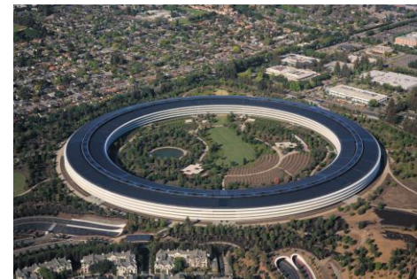
本社屋根には17MWの太陽光発電設備 (Daniel L. Lu/Wikimedia Commons)
