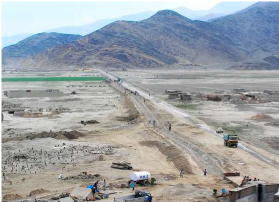
砂漠化した平野に用水路建設が始まる 2005年
